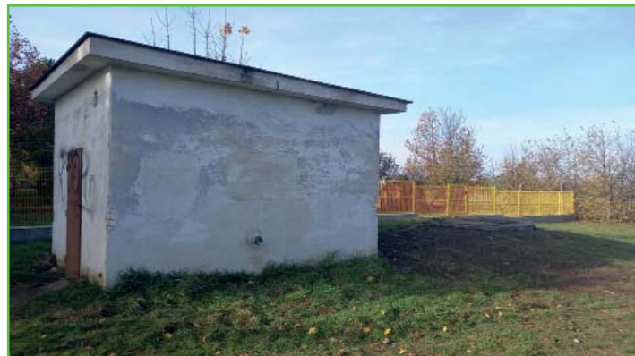
Dokončena modernizace strojího vybavení studny na Sídlišti (foto Pavel Kadlec)
