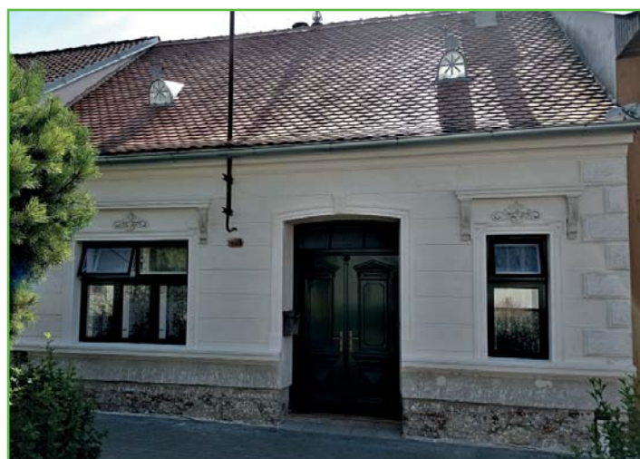
Nynější stav domu Masarykova 65 během rekonstrukce
