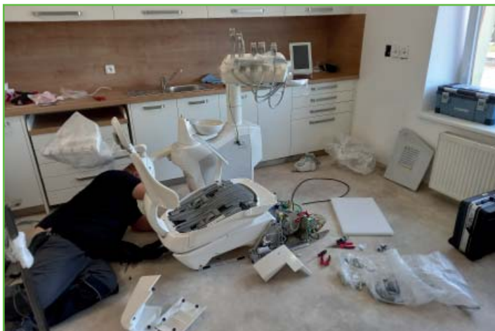
Instalace zubařského křesla do ordinace (foto Pavel Kadlec)
