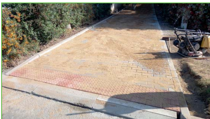
Rekonstrukce chodníku k vlakovému podchodu (foto Pavel Kadlec)
